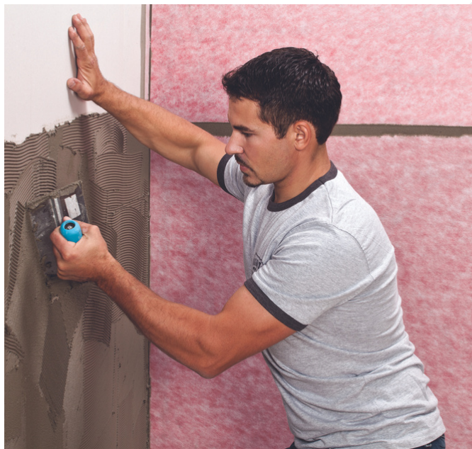
Aplicación de adhesivo cementicio al muro
