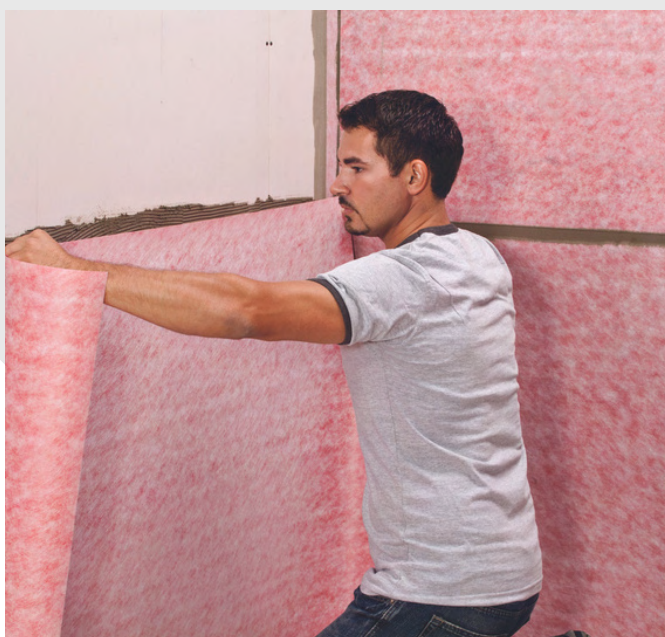
Instalar la membrana para zonas húmedas Aqualay de manera uniforme y dejar secar
