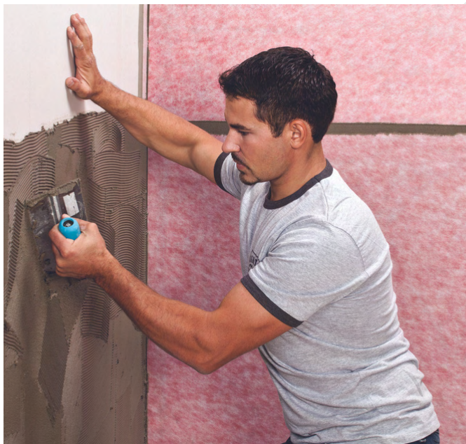
Aplicación de adhesivo cementicio al muro
