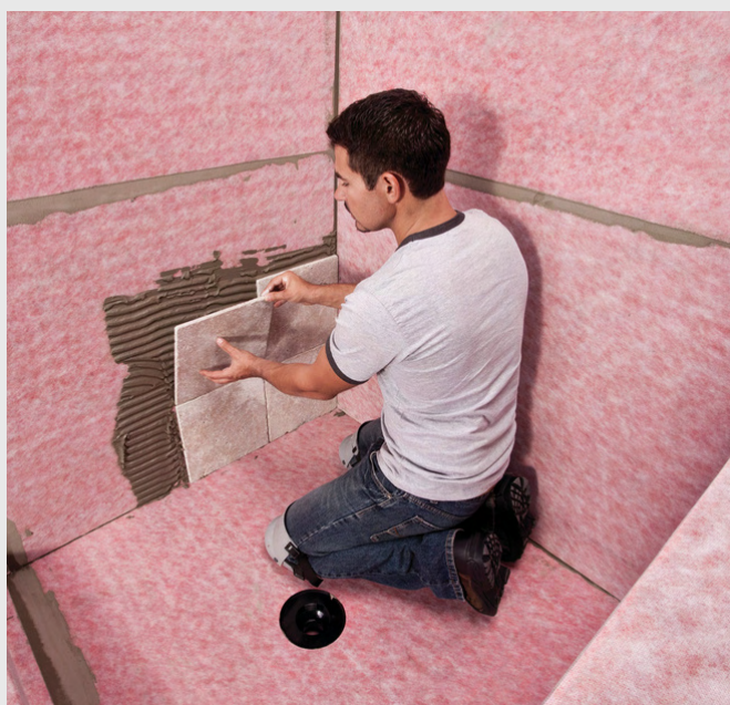
Luego de instalación se procede a instalar el cerámico o porcelanato
