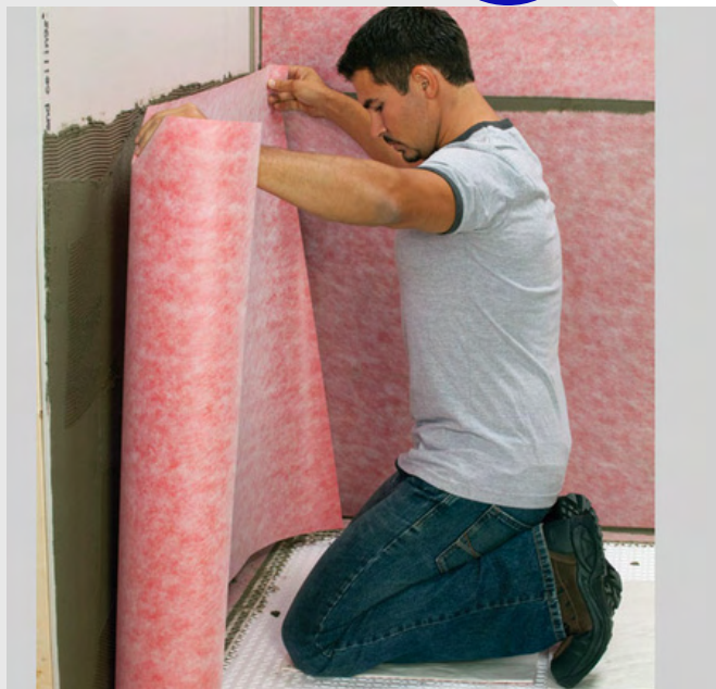
Posicionar la membrana para zonas húmedas Aqualay en la superficie a impermeabilizar
